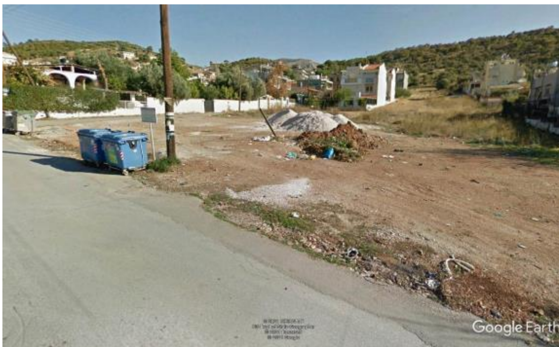
Φωτογραφία 10: Θέση αντλιοστασίου ακαθάρτων Σ8.1
