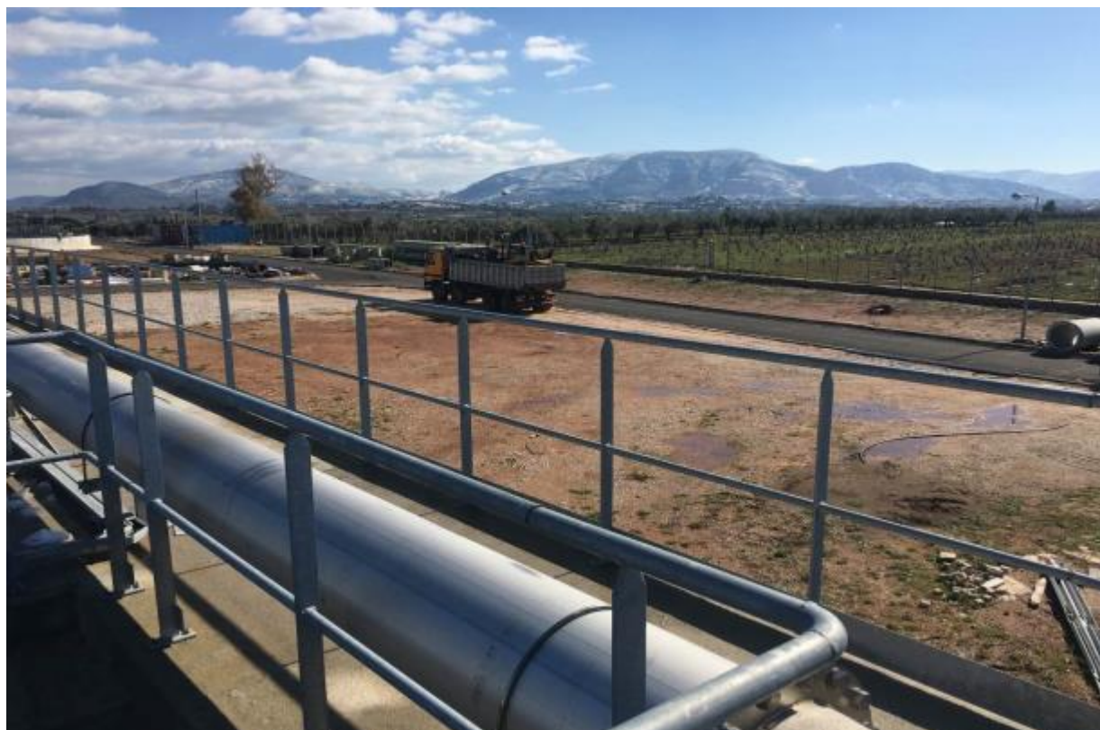
Φωτογραφία 14: Γήπεδο ΚΕΛ Κορωπίου – Παιανίας. Θέση χωροθέτησης της νέας μονάδας προεπεξεργασίας – λεπτοεσχάρωσης (νέα μονάδα Α2)
