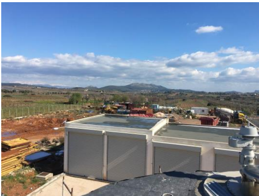
Φωτογραφία 19: Γήπεδο ΚΕΛ Κορωπίου – Παιανίας. Όπισθεν του υφιστάμενου κτιρίου αφυδάτωσης διακρίνεται η θέση χωροθέτησης των νέων μονάδων A23, A24, A25 & A26
