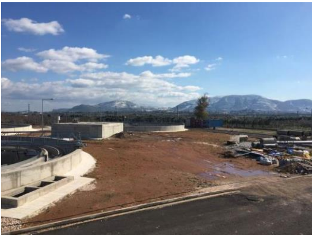
Φωτογραφία 16: Γήπεδο ΚΕΛ Κορωπίου – Παιανίας. Θέση χωροθέτησης της νέας μονάδας πρωτοβάθμιας καθίζησης και του Α/Σ ενδιάμεσης ανύψωσης (νέα μονάδα Α3)
