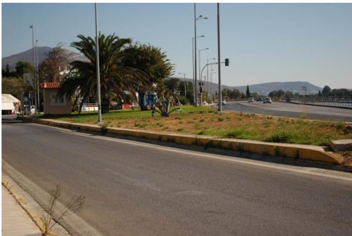
Φωτογραφία 8: Θέση αντλιοστασίου ακαθάρτων Σ7
