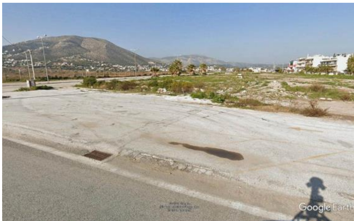
Φωτογραφία 2: Θέση αντλιοστασίου ακαθάρτων Σ1
