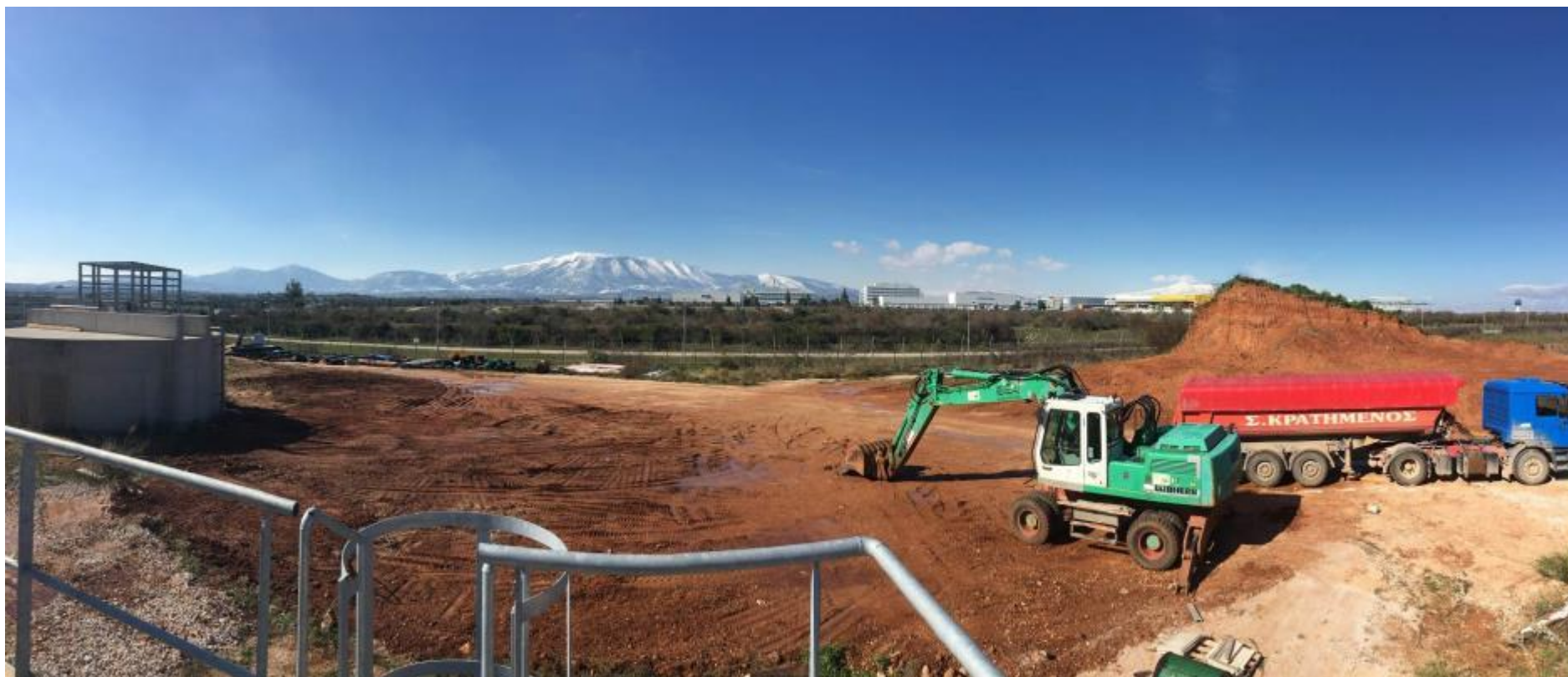
Φωτογραφία 22: Πανοραμική άποψη του βόρειου τμήματος του γηπέδου του ΚΕΛ Κορωπίου – Παιανίας. Θέση χωροθέτησης των νέων μονάδων Α8, Α9 & Α10.
