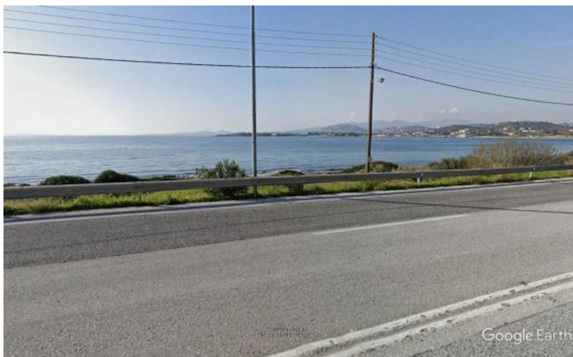
Φωτογραφία 6: Θέση αντλιοστασίου ακαθάρτων Σ5
