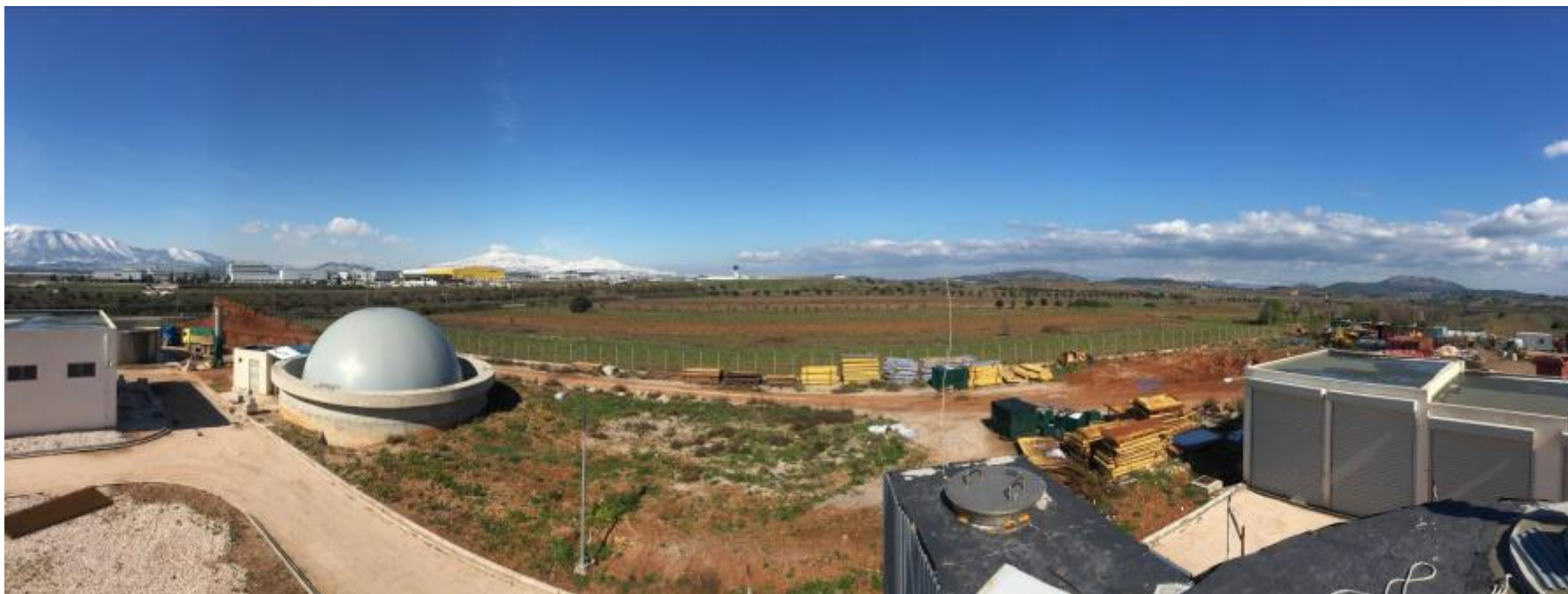
Φωτογραφία 21: Πανοραμική άποψη του χώρου κατασκευής των νέων έργων βορειοανατολικά του γηπέδου Κορωπίου – Παιανίας. Θέση χωροθέτησης των νέων μονάδων A4, A5, A6, A7 & A12.
