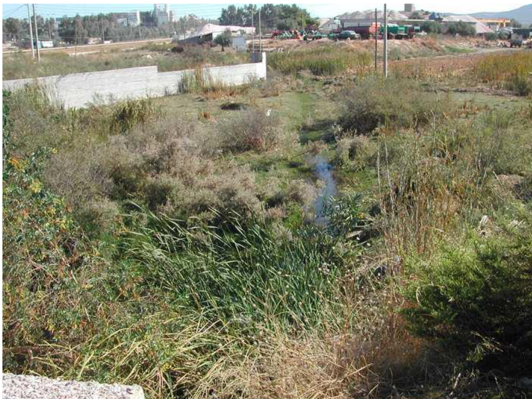
Φωτογραφία 23: Η φυσική κοίτη του ρέματος Καλυβίων περί της διατομής ΔΚΑ-3
