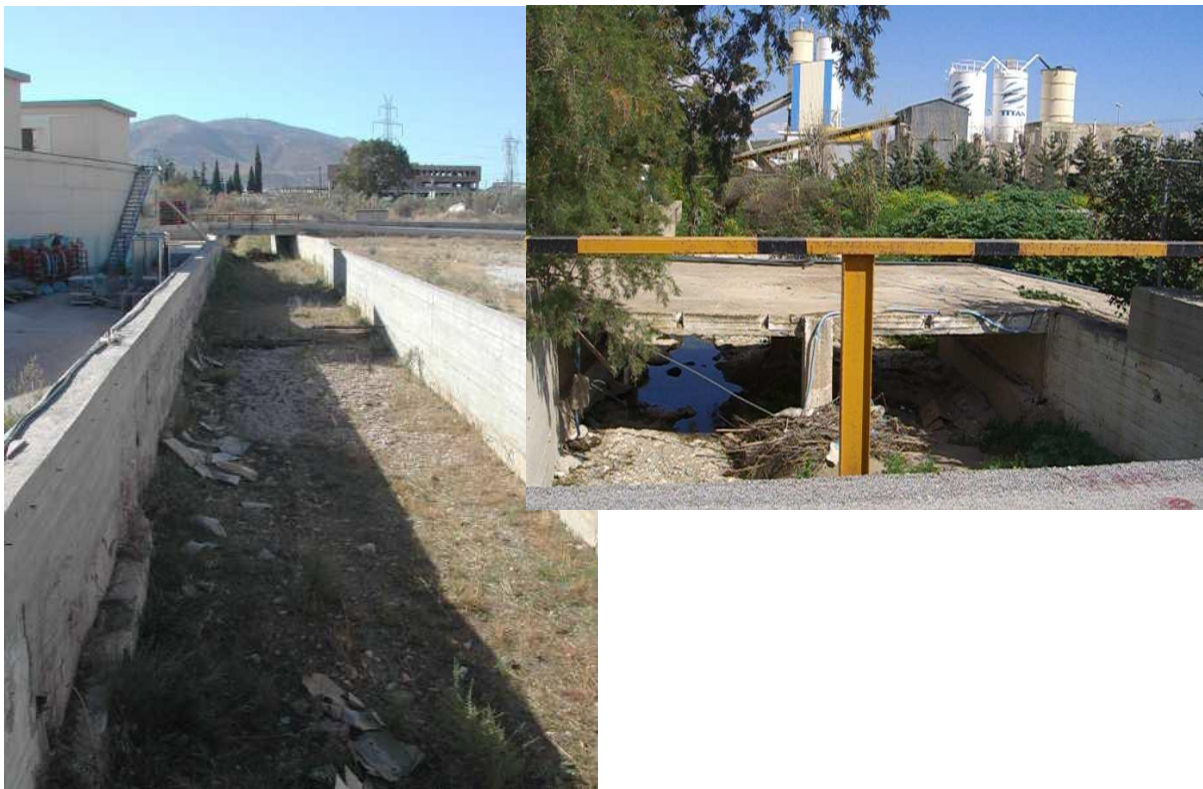
Φωτογραφία 17: Σποραδικά έργα διευθέτησης και πλακοσκεπής οχετός (άναντη και κατόντη της διατομής ΔΚΒ-57 αντίστοιχα)
