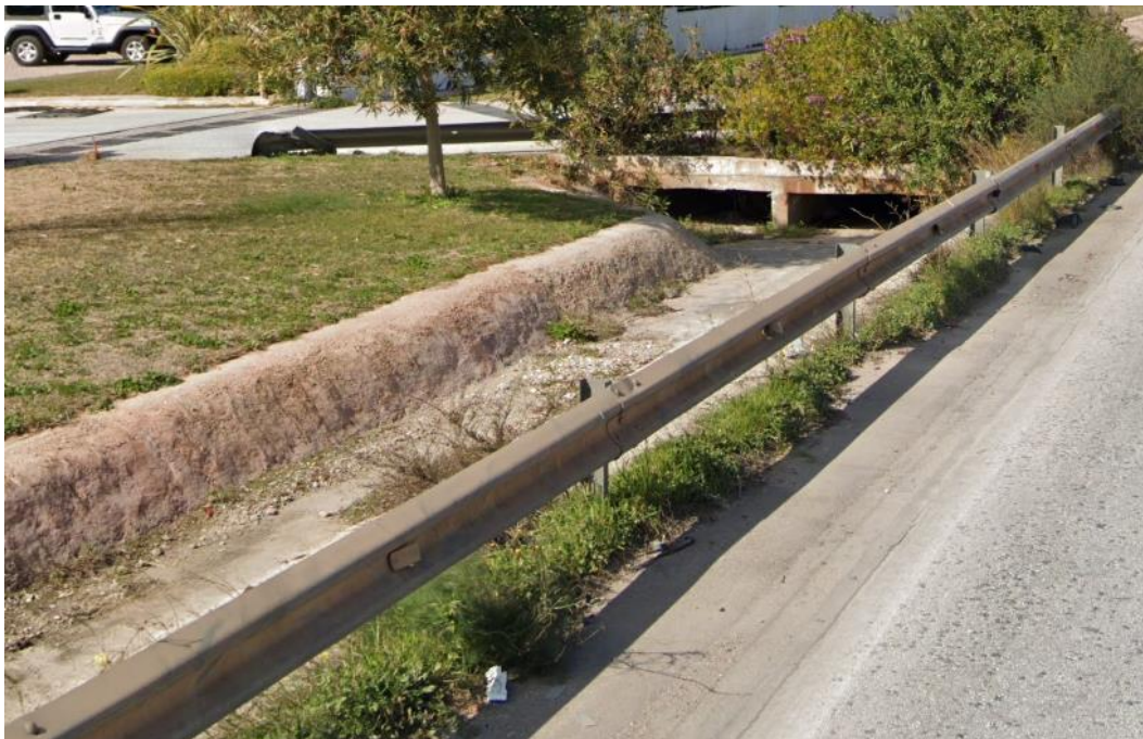
Φωτογραφία 20: Το υφιστάμενο τεχνικό διέλευσης του ρέματος Κουβαρά στη Λεωφόρο Λαυρίου (κατάντη της διατομής ΔΚΒ-33)
