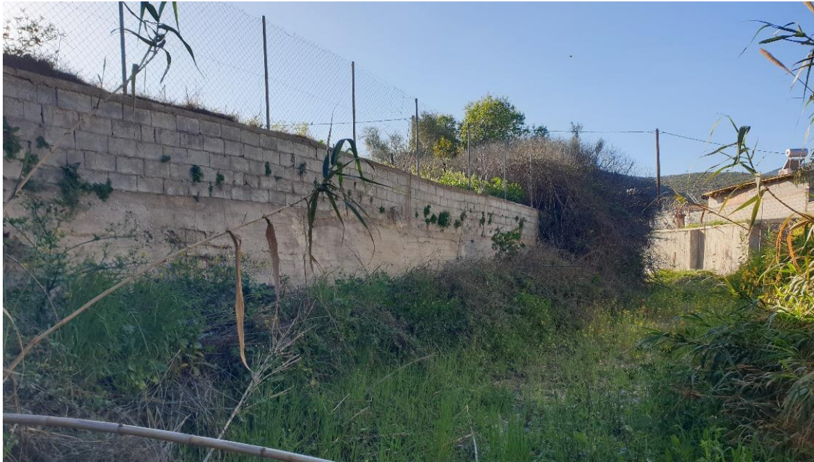
Φωτογραφία 1: Άποψη του ρέματος Κουβαρά περί της διατομής ΔΚΒ-140. Διακρίνεται υφιστάμενο τοίχιο με φράχτη από συρματόπλεγμα στην περιοχή της δεξιάς όχθης (λήψη: Μάρτιος 2023, κατεύθυνση της λήψης: ΝΑ)
