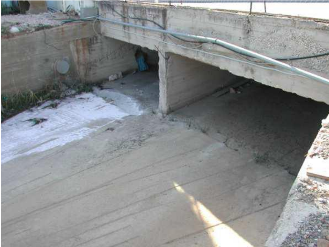
Φωτογραφία 16: Υφιστάμενος πλακοσκεπής οχετός κατόντη της διατομής ΔΚΒ-83
