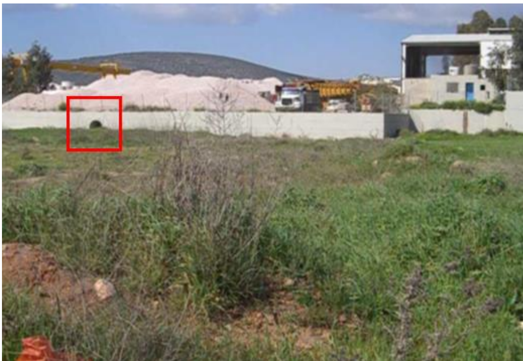
Φωτογραφία 25: Τεχνικό διέλευσης του ρέματος Καλυβίων μέσω του χώρου επεξεργασίας αδρανών (σωληνωτός οχετός)
