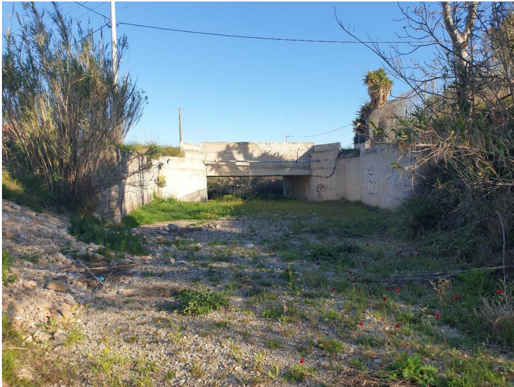
Φωτογραφία 8: Άποψη ανάντη του τεχνικού της Λεωφόρου Σουνίου στο ρέμα Κουβαρά
