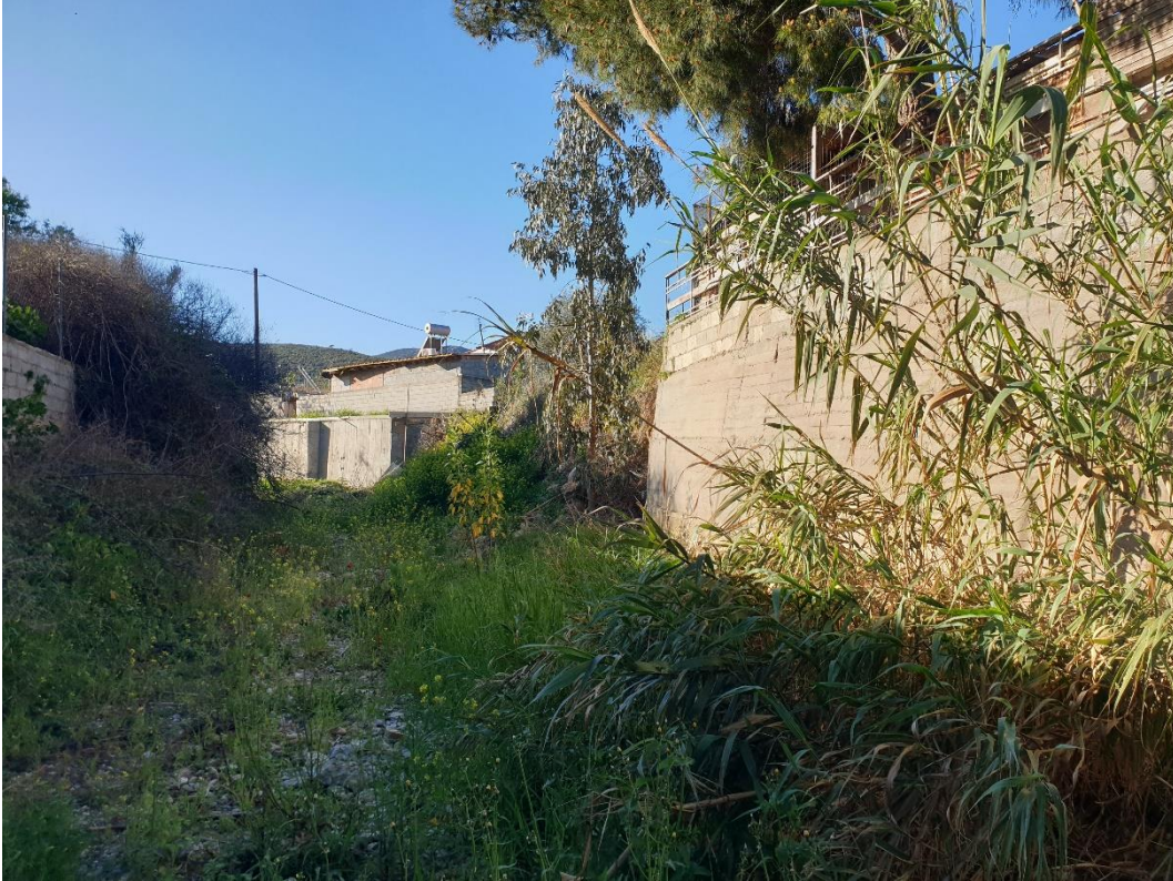
Φωτογραφία 2: Άποψη του ρέματος Κουβαρά περί της διατομής ΔKB-140. Διακρίνεται υφιστάμενο τοίχιο στην περιοχή της δεξιάς όχθης (λήψη: Μάρτιος 2023, κατεύθυνση της λήψης: N)
