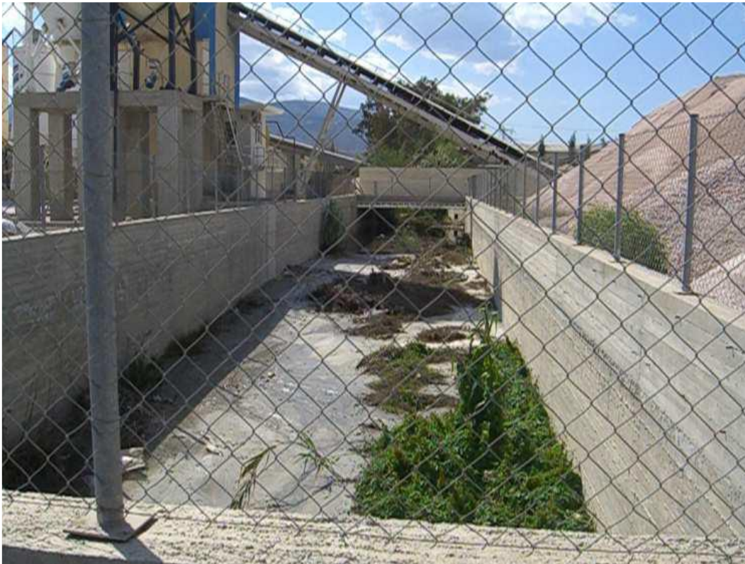
Φωτογραφία 18: Σποραδικά έργα διευθέτησης περί της διατομής ΔΚΒ-45
