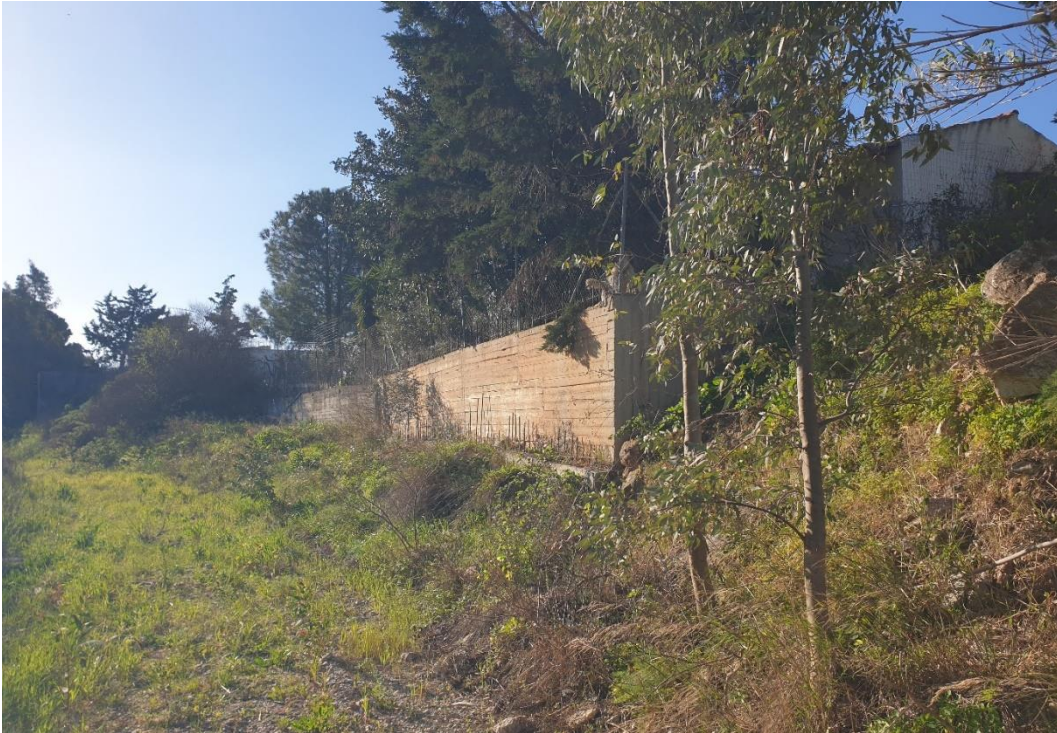
Φωτογραφία 6: Άποψη της κοίτης του ρέματος Κουβαρά περί της διατομής ΔΚΒ-136. Διακρίνεται υφιστάμενο τοιχίο με φράχτη από συρματοπλέγμα στην περιοχή της αριστερής όχθης (λήψη: Μάρτιος 2023, κατεύθυνση της λήψης: Ν)
