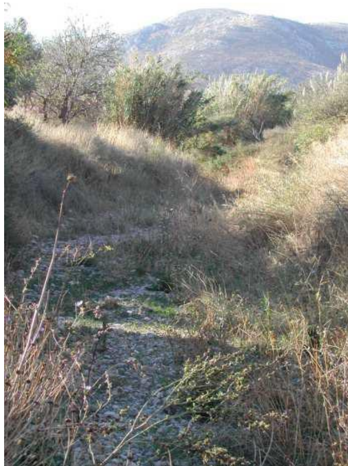
Φωτογραφία 13: Η φυσική κοίτη του ρέματος Κουβαρά περί της διατομής ΔΚΒ-107
