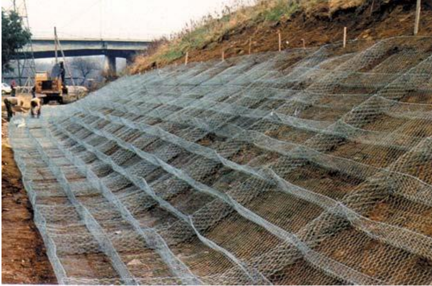
Σχήμα 2.3: Τοποθέτηση στρωμών για την προστασία του πρανούς ρέματος
