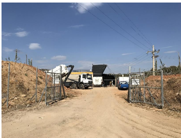
Εικόνα 16 Εγκατάσταση ΣΜΑ Δήμου Μαркоπούλου Μεσογαίας
