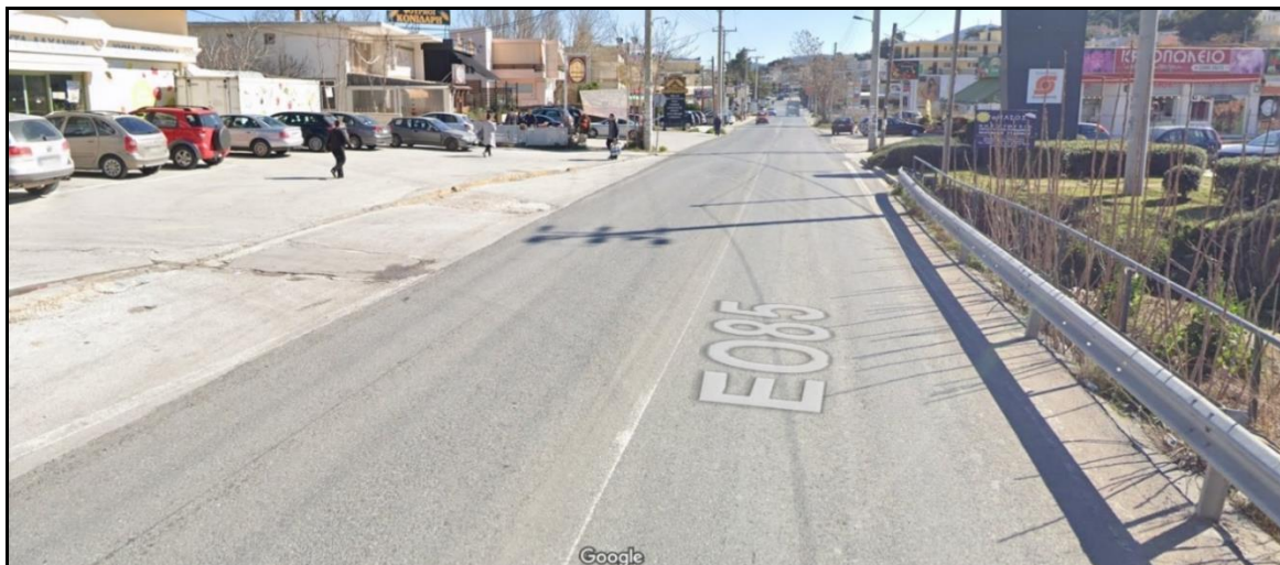
Εικόνα 9. Οδός Αυλακίου χωρίς πεζοδρόμηση
